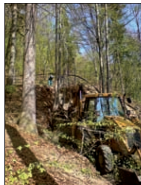
Výkop rýhy pro vodovodní přípojku k Javoříčským jeskyním v dubnu 2009. Foto: Stanislav Výbiral
