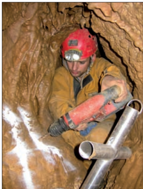
Jeskyňář Vojtěch Heger připravuje kotvení pro uzamykatelnou mříž v chodbě k Liščí díře. Foto: Dalibor Janák ml.
