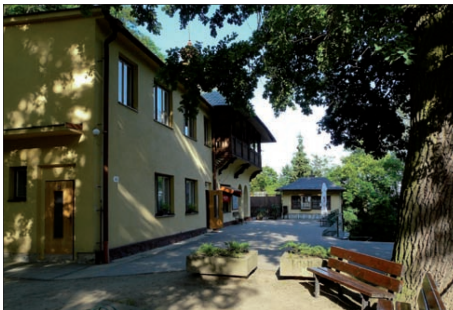
Provozní budova Mladečských jeskyní před plánovanou rekonstrukcí. Foto: Drahomíra Coufalová
