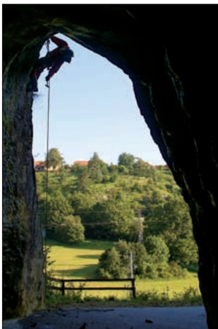
Kontrolu a obírku uvolněné horniny v portále Jeskyně Balcarky je nutno provádět speleoaipinistickým způsobem. Foto: Jan Flek
