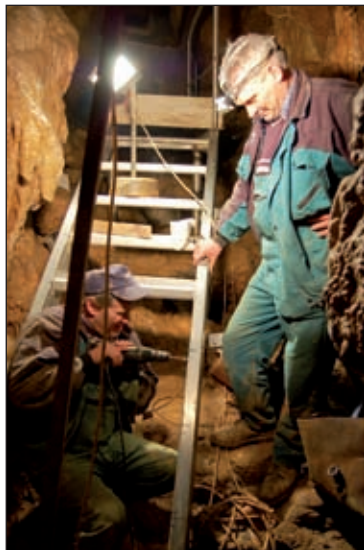
Zámečníci Jiří Bílek a Jaroslav Špidlík při montáži nerezových schodišť v Jeskyni Balcarka. Foto: Jiří Hebelka
