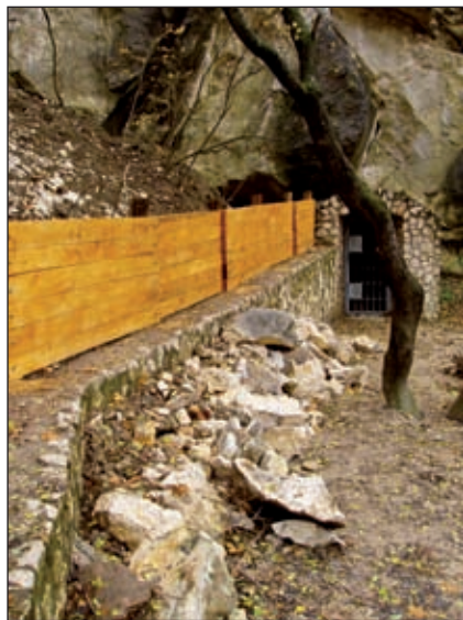
Čerstvě vybudovaná ochranná palisáda u vchodu do Jeskyně Na Turoldu s uloženými bloky „obranými“ z okolních skalních stěn. Foto: Jiří Kolařík
