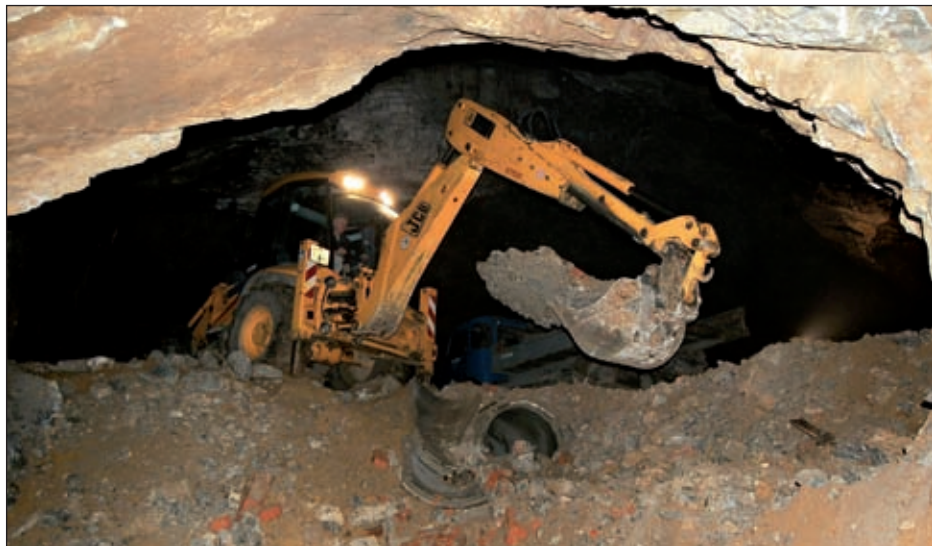
Na odstraňování zazdívek a zakládek ve Výпустku nastoupila skutečně „těžká“ technika. Foto: Jiří Hebelka
