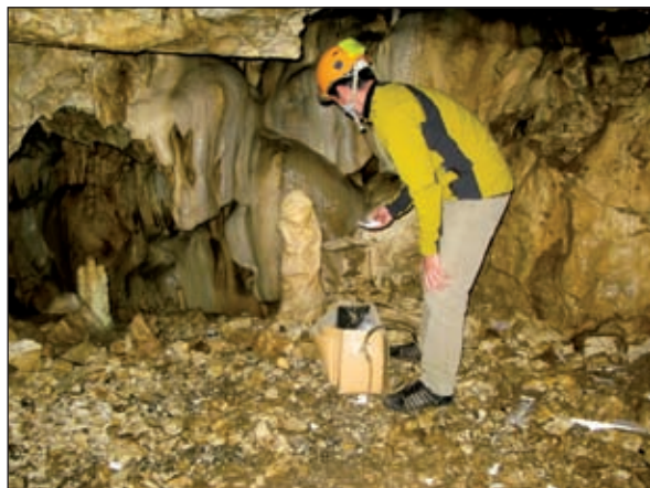
Provozní technik Martin Kubalák kontroluje stav elektroinstalace v jeskyních po úderu blesku. Foto: Petr Kubalák
