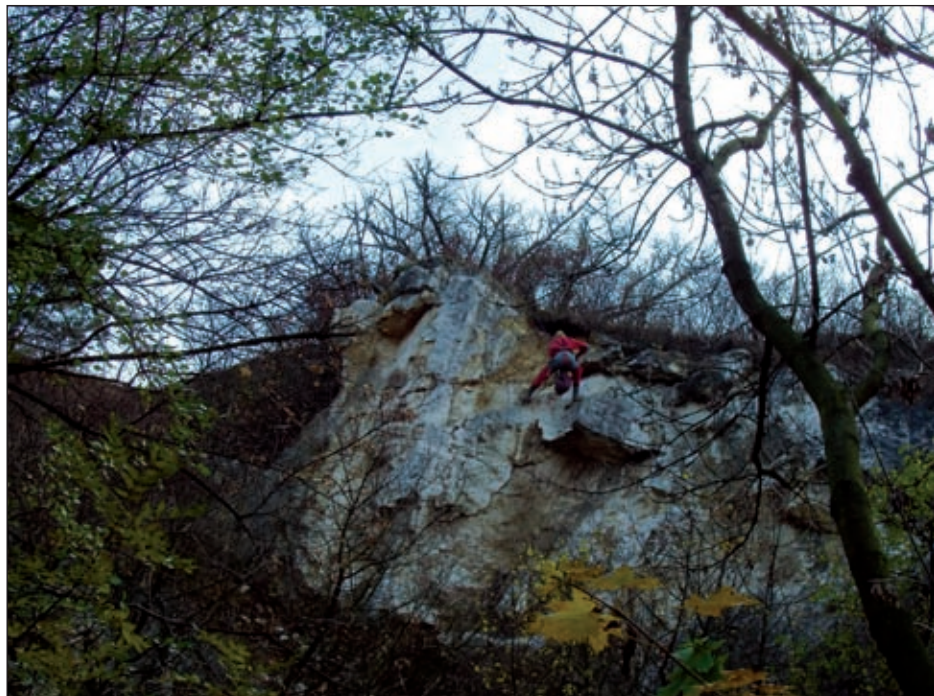
Snímek zachycuje kontrolu a obírku skalních stěn nad turistickou stezkou v PR Turolď. Foto: Jiří Kolařík
