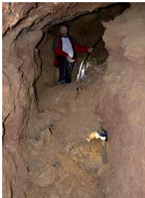
Sesuv podmáčených sedimentů v chodbě na Galerii.
