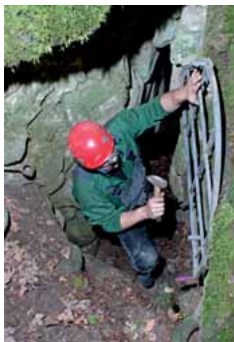
Práce na úpravě vchodu do jeskyně Bětník. Foto: Petr Zajiček, SJ ČR
