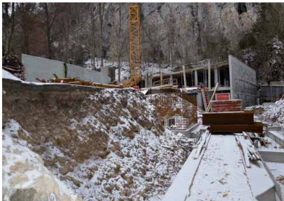
Stav stavebních prací u Punkevních jeskyní na Silvestra 2014. Foto: Jiří Hebelka, SJ ČR
