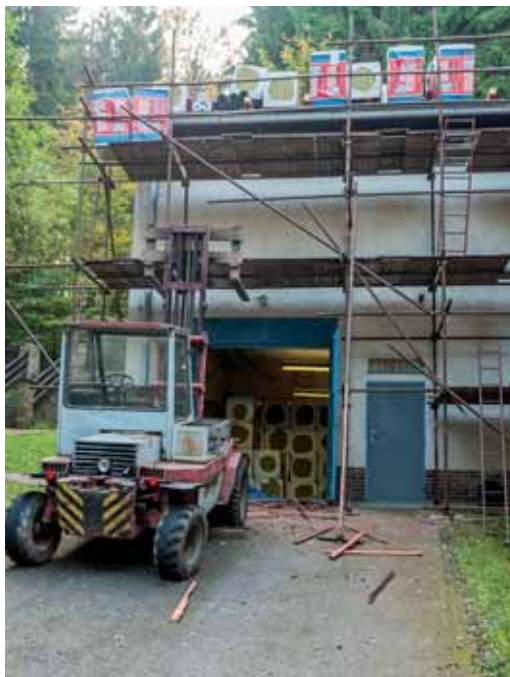
Doprava izolační vaty z garáže na střechu provozní budovy Bozkovských dolomitových jeskyní.
