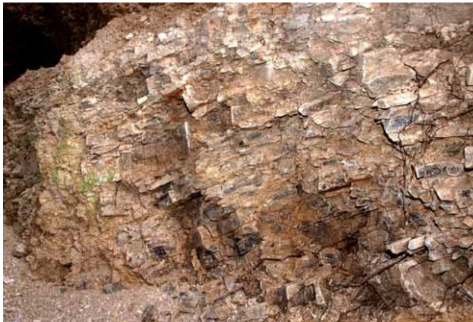
Menilitové souvrství v základu novostavby. Foto: Jiří Kolařík, SJ ČR
