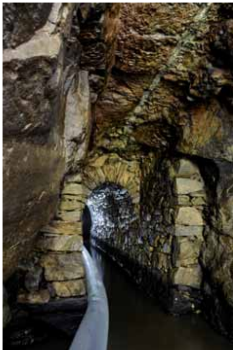
Některé úseky štolý jsou raženy po tektonických poruchách nebo sledují žilné struktury. Plastový rukáv přiváděl čerstvý vzduch až do vzdálenosti 500 m od šachty č. 7. Foto: Josef Vandělik, SJ ČR
