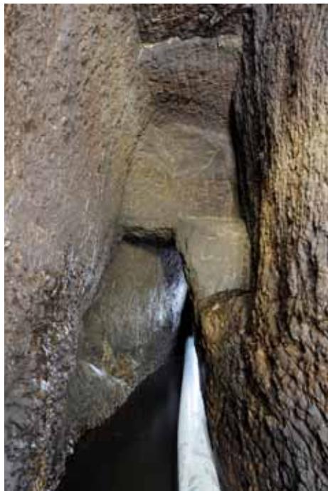
Typickým ručně raženým profilem dědičné štolý Eliáš je lichoběžník. Na snímku výškově rozdílné úrovně profilů v místě setkání protičeleb.
