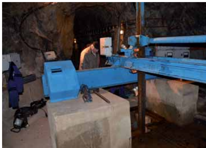
Oprava stavidel ve stavidlové komoře. Foto: Jiří Hebelka, SJ ČR
