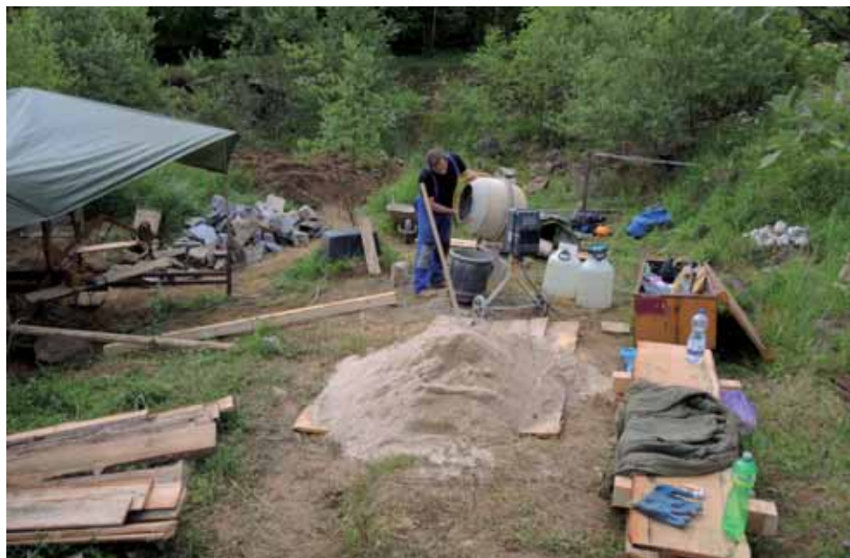
Lokalita po určitou dobu připomínala spíše staveniště. Foto: Luboš Hájek
