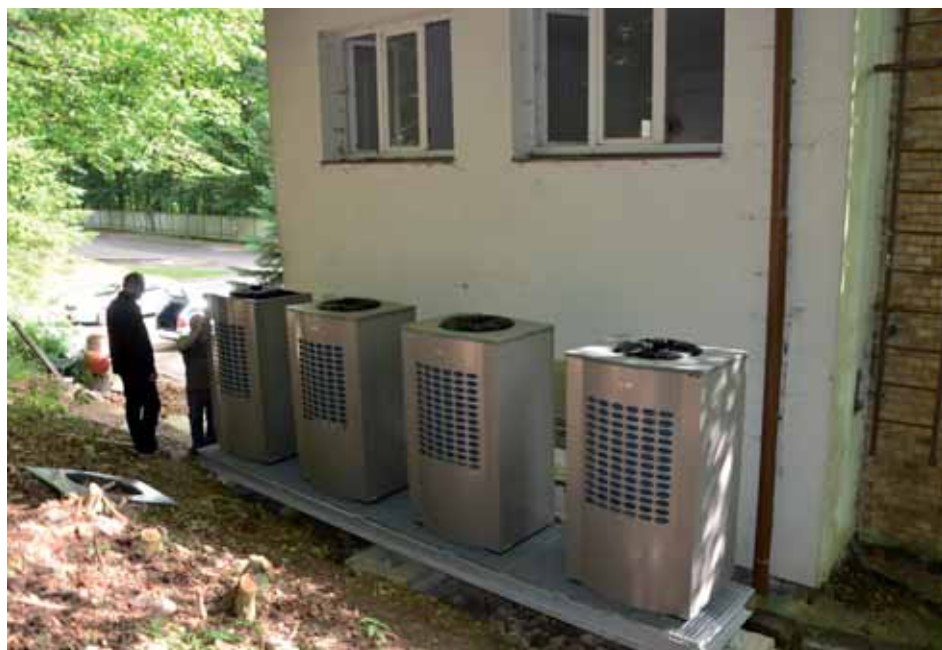
Instalace tepelných čerpadel pro správní budovu jeskyně Výpustek. Foto: Jiří Hebelka, SJ ČR
