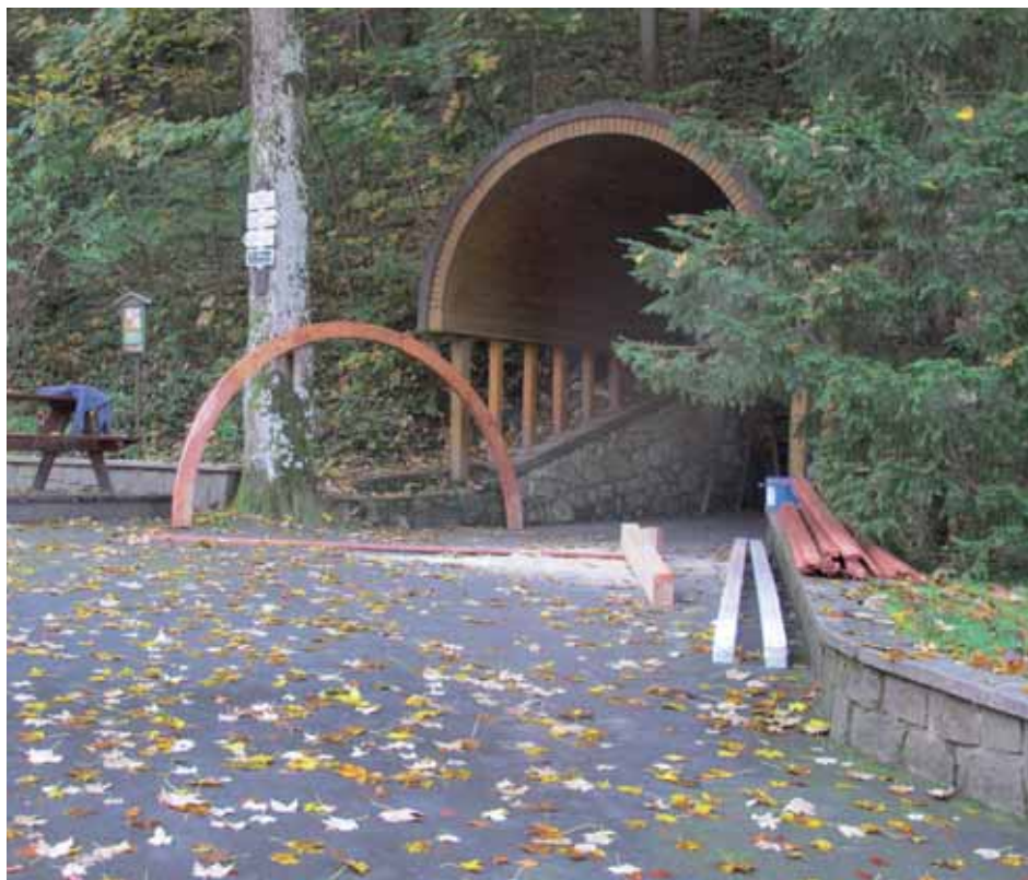
Oprava vstupního portálu Jeskyně Na Pomezí. Foto: Martin Kubalák, SJ ČR
