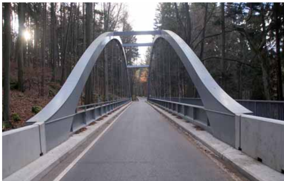
Nové mostní těleso po výstavbě v roce 2014. Foto: Jan Flek, SJ ČR
