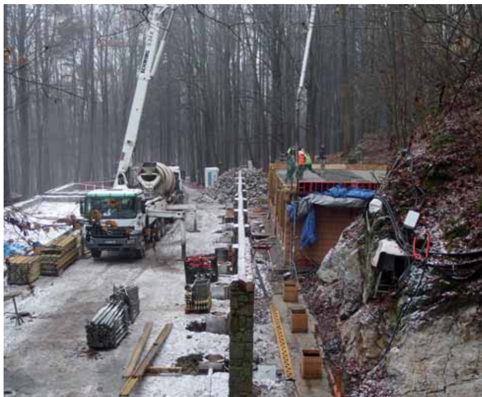
Betonování stropu provozní budovy Javoříčských jeskyní v prosinci 2014. Foto: Pavel Šišma, SJ ČR
