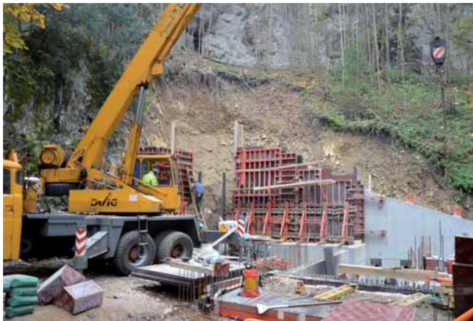
Výstavba opěrné stěny k zajištění nestabilního svahu. Foto: Jiří Hebelka, SJ ČR
