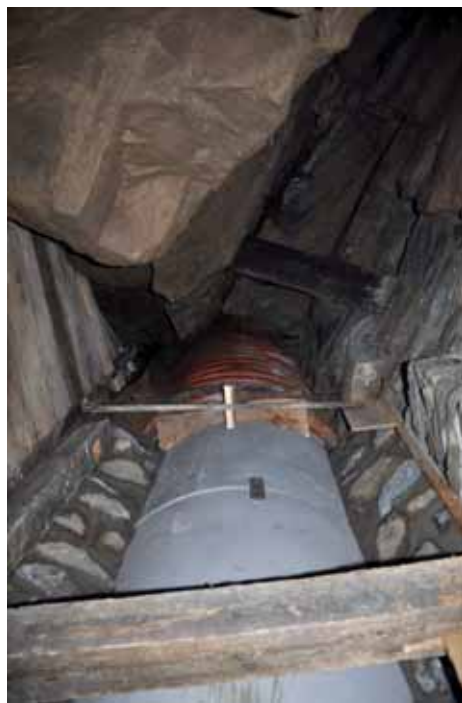
Úpravy provedené ve spodní části vstupní šachtice. Foto: František Krejča, SJ ČR
