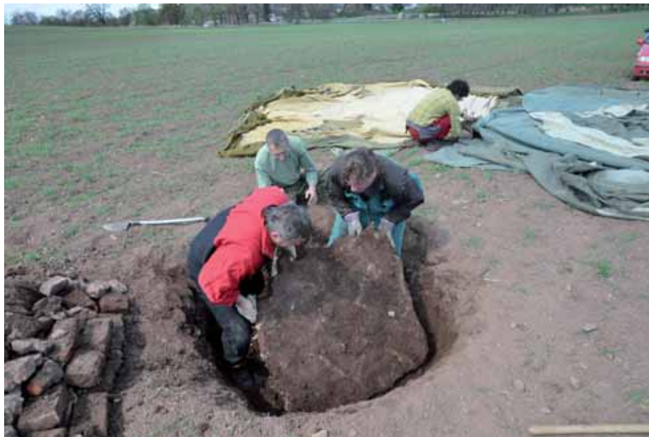
Otevření ústí větrací šachty č. 7. Foto: Josef Vandělik, SJ ČR
