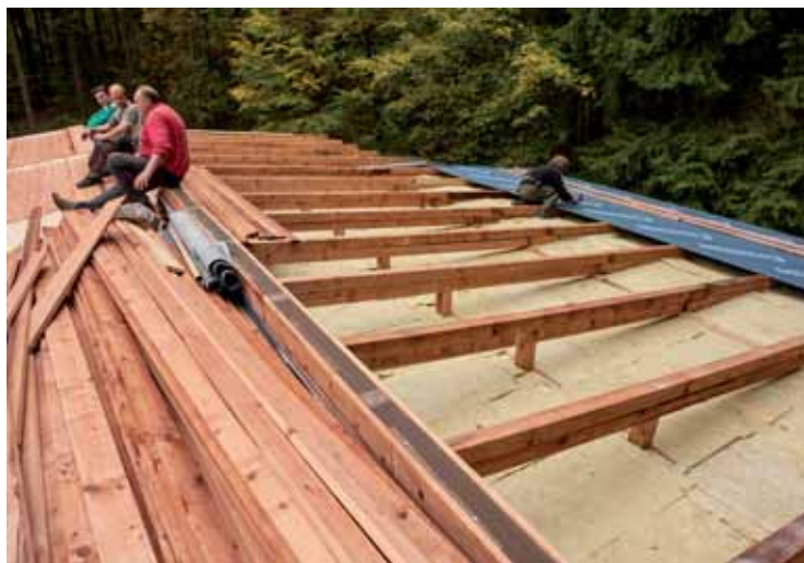
Rodící se nová střecha provozní budovy Bozkovských dolomitových jeskyní.
