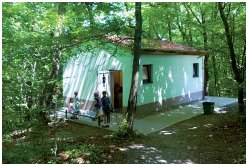
Zrekonstruované veřejné WC u Koněpruských jeskyní. Foto: Alexandr Komaško, SJ ČR
