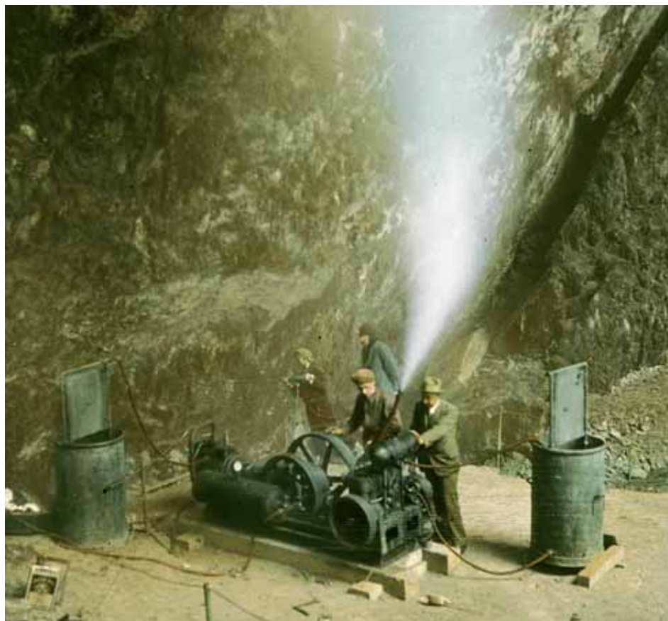
Kompresorová stanice na dně Macochy. Archiv SJMK
