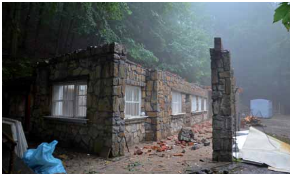
Demolice původní provozní budovy Javoříčských jeskyní. Foto: Milan Hladký, SJ ČR
