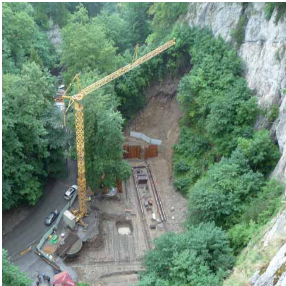
Celkový pohled na staveniště ze skalní stěny nad Punkevními jeskyněmi. Foto: Martin Žanda
