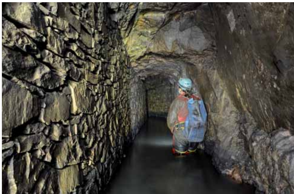
Kamenné zidky často až několik desítek metrů dlouhé ukrývají překopy k některým větracím šachtám nebo zajišťují porušené úseky štoly. Foto: Josef Vandělik, SJ ČR
