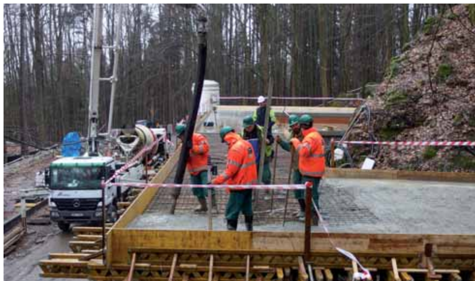
Betonování stropu nové budovy v březnu 2015. Foto: Pavel Šišma, SJ ČR
