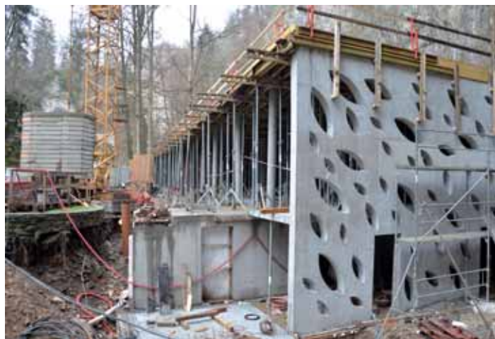
Nová provozní budova se postupně klube na svět, stav v lednu 2015.
