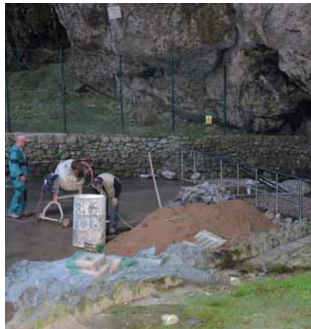
Firma Radovana Jedličky provádí opravu návštěvního platu na dně Macochy. Foto: Jiří Hebelka, SJ ČR
