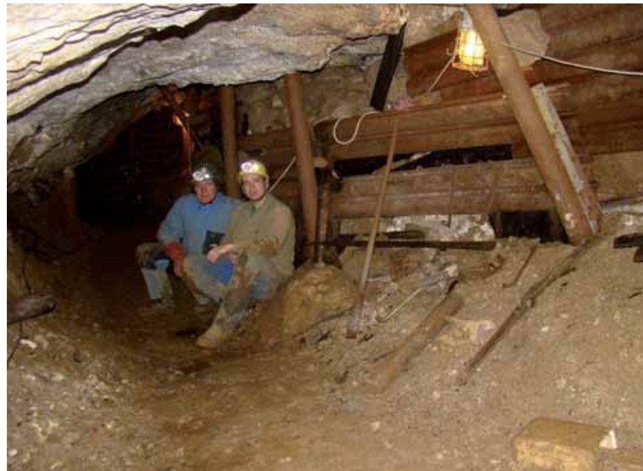
Hochstetterova síňka, místo vyústění větrací šachty č. II a nezbytné zapažení chodby směřující do Salmova Výпустku, prosinec 2007. Foto: Zdeněk Cihlář
