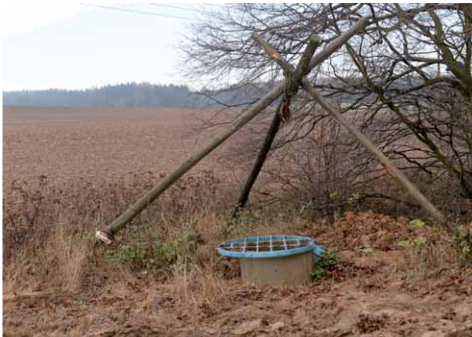
Nejseverněji situovaná jeskyně Moravského krasu, Ponor pod Brusnou, K2301210-J-00012. Vchod opatřený skružemi a mřížovou uzávěrou. Foto: Olga Suldovská, SJ ČR
