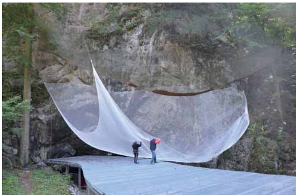
Instalace nových ochranných sítí nad přístavištěm u Punkevních jeskyní. Foto: Jiří Hebelka, SJ ČR
