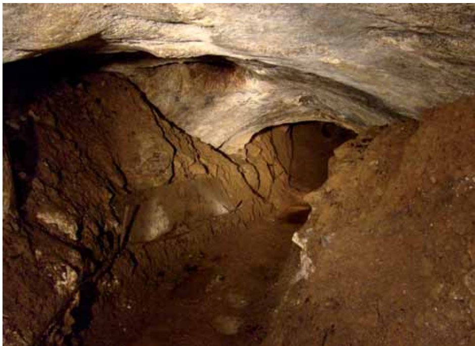
Babická chodba, stav v prosinci 2007. Foto: Zdeněk Cihlář
