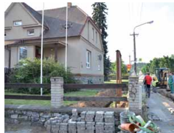
Pokládka kanalizačních přípojek k objektům SJMK na Svitavské ulici v Blansku. Foto: Jiří Hebelka, SJ ČR
