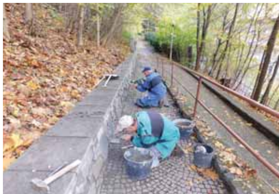
Pánové Jiří Bílek a Jaroslav Špidlík při opravě opěrné zdi podél přístupového chodníku ke Zbrašovským aragonitovým jeskyním.
