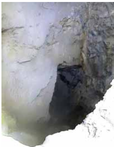
Staré dobývky na Božídulské žíle. Na snímku pořízeném kamerou v hloubce 17 m je dobře vidět ústí slepé jámy a typický lichoběžníkový profil navazující chodby. Foto: Josef Vandělík, SJ ČR
