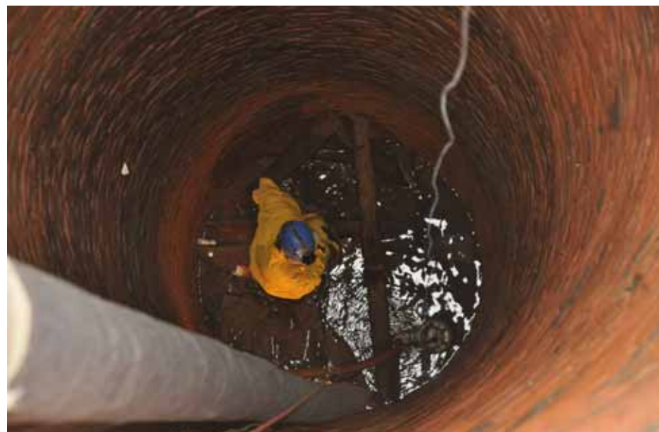
Čištění obecní studny v Horkách u Tábora, na snímku jeskyňář Zbyněk Roubal. Na povrchu zásypu jsou patrné trámy dřevěné konstrukce původního rumpálu. Foto: František Krejča, SJ ČR
