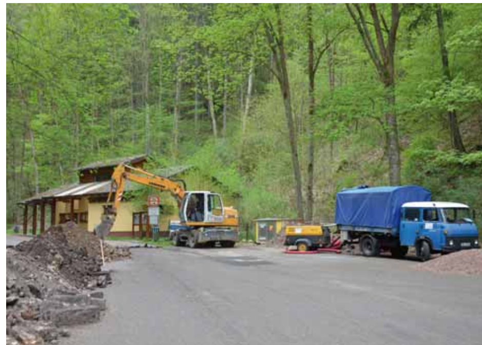
Budování nové trafostanice u Kateřinské jeskyně. Foto: Jiří Hebelka, SJ ČR
