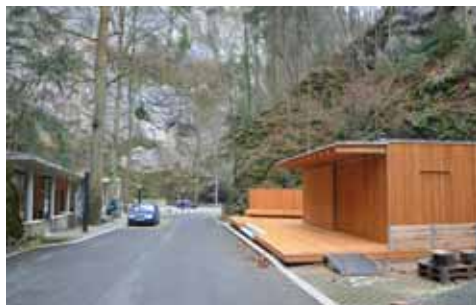
Kiosek s občerstvením vyrostl v těsné blízkosti nové provozní budovy Punkevních jeskyní.
