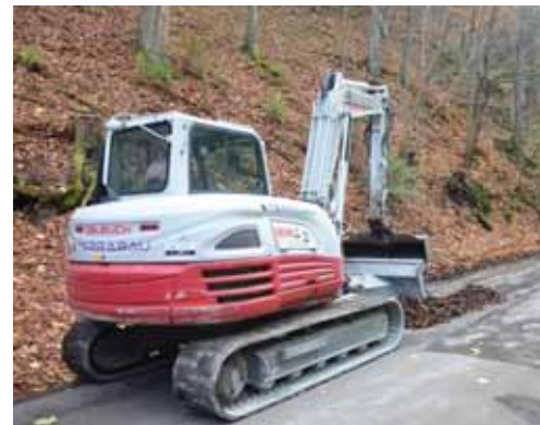
Oprava povrchu vozovky mezi Skalním mlýnem a Punkevními jeskyněmi v listopadu 2017.
