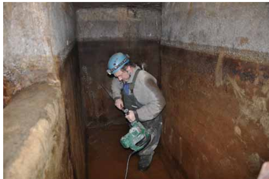
Jímací objekt lázni vybudovaný před ústím dědičné štoly Jan Nepomucký. František Krejča připravuje vrtání otvorů pro kamerový průzkum. Foto: Luboš Hájek
