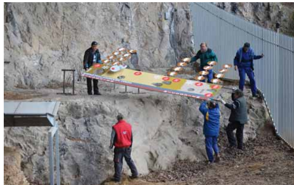
Instalace nových panelů k archeologickým profilům v jeskyni Kůlna. Foto: Jiří Hebelka, SJ ČR
