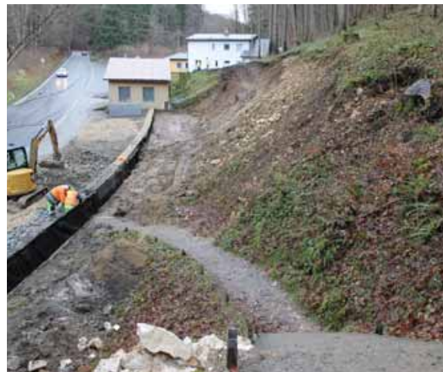
Zahájení stavby výstupního chodníku od východu z Jeskyní Na Pomezí.
