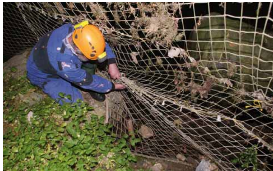
Čištění a oprava ochranné sítě nad Dolním jezírkem na dně Macochy. Foto: Jan Flek, SJ ČR
