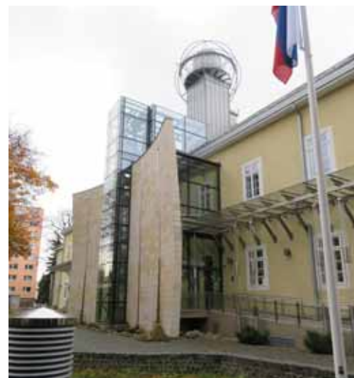
Nákladem 9,5 mil. eur zrekonstruovaná budova kláštera v Liptovském Mikuláši, dlouholeté sídlo Slovenského múzea ochrany prírody a jaskyniarstva.
