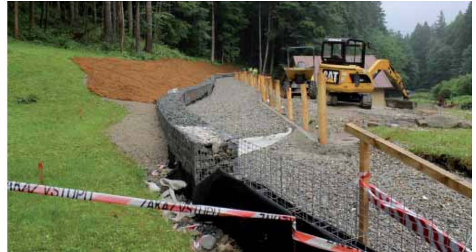
Výstavba chodníku u Jeskyni Na Pomezí, červen 2018. Foto: Martin Kubalák, SJ ČR
