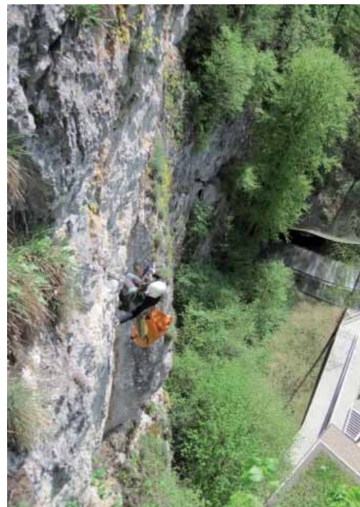
Obírka skalní stěny nad areálem Punkevních jeskyní. Foto: Jiří Hebelka, SJ ČR
