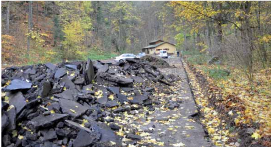
Oprava parkoviště u Kateřinské jeskyně, listopad 2018. Foto: Jiří Hebelka, SJ ČR
