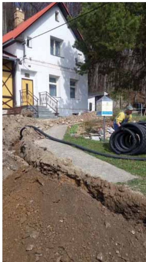
Nový přívodní kabel k Jeskyni Na Špičáku bude už brzo uložen do výkopu. Foto: Evelyna Vozábalová, SJ ČR
