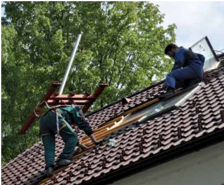
František Krejča a Josef Vandělik instalují držák antény firmy Gity na střešku provozní budovy. Foto: archiv SCHJ.
