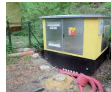
Osazování nové trafostanice u Kateřinské jeskyně, květen 2018. Foto: Jiří Hebelka, SJ ČR
