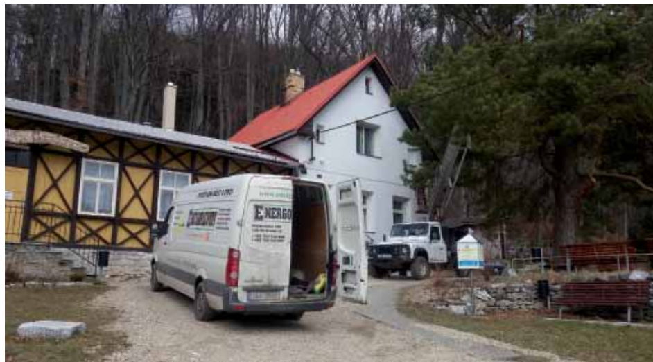
Připravuje se nový přívod elektřiny do nové pojistkové skříně v provozní budově Jeskyně Na Špičáku, březen 2018. Foto: Evelyn Vozábalová, SJ ČR
