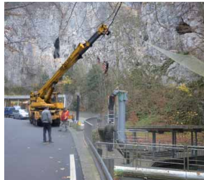
Instalace jeřábu u Punkevních jeskyní. Foto: Jiří Hebelka, SJ ČR
