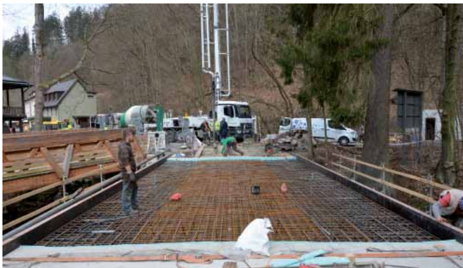
Výstavba nového mostu přes Punkvu u Skálního mlýna. Foto: Jiří Hebelka, SJ ČR
