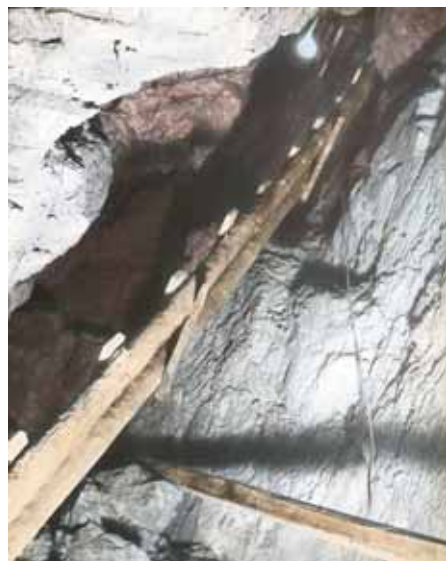
První úsek vystrojení „Starého vchodu“. Archiv SZAJ
