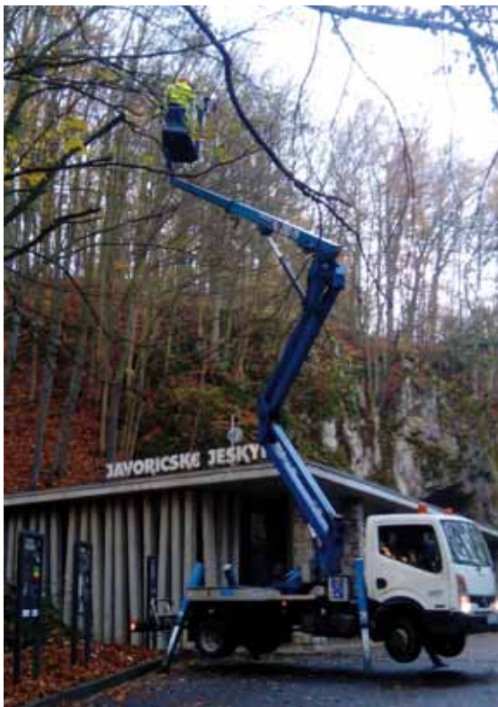
Odstraňování suchých větví v bezprostřední blízkosti provozní budovy Javoříčských jeskyní. Foto: Pavel Šišma, SJ ČR
