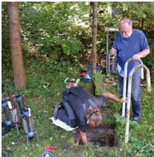
Robert Dvořáček (vpravo) při výměně čerpadel v odpadní jímce u provozní budovy Jeskyně Výпустek. Foto: Jiří Hebelka, SJ ČR
