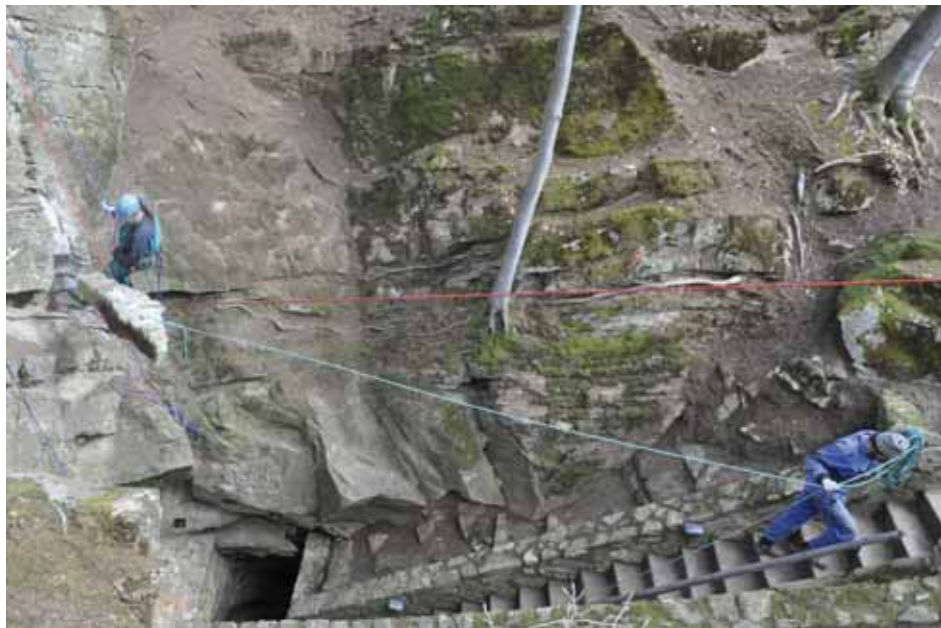
Blok po spuštění do traversy, František Krejča kontroluje jeho zavěšení, Josef Vandělík přesunuje břemeno mimo „ohroženou oblast“. Foto: Hana Štěrbová, SJ ČR
