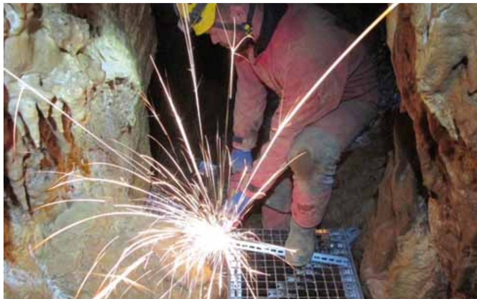
Nové můstky instalované na konci Březinské chodby cestou k Černé propasti výrazně zvyšují bezpečnost badatelů, mj. i při sčítání letounů. Foto: Luboš Kadidlo
