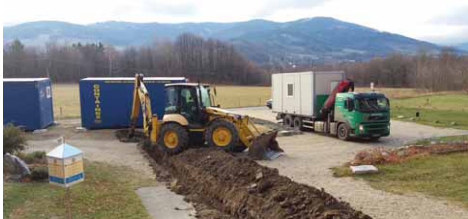
Příprava provizorního zázemí po dobu rekonstrukce provozní budovy. Foto: Evelyna Vozábalová, SJ ČR
