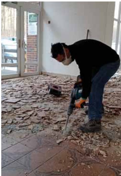
Stará dlažba v hale dosloužila a navíc v zimě nepříjemně klouzala. Foto: Martin Kubalák, SJ ČR
