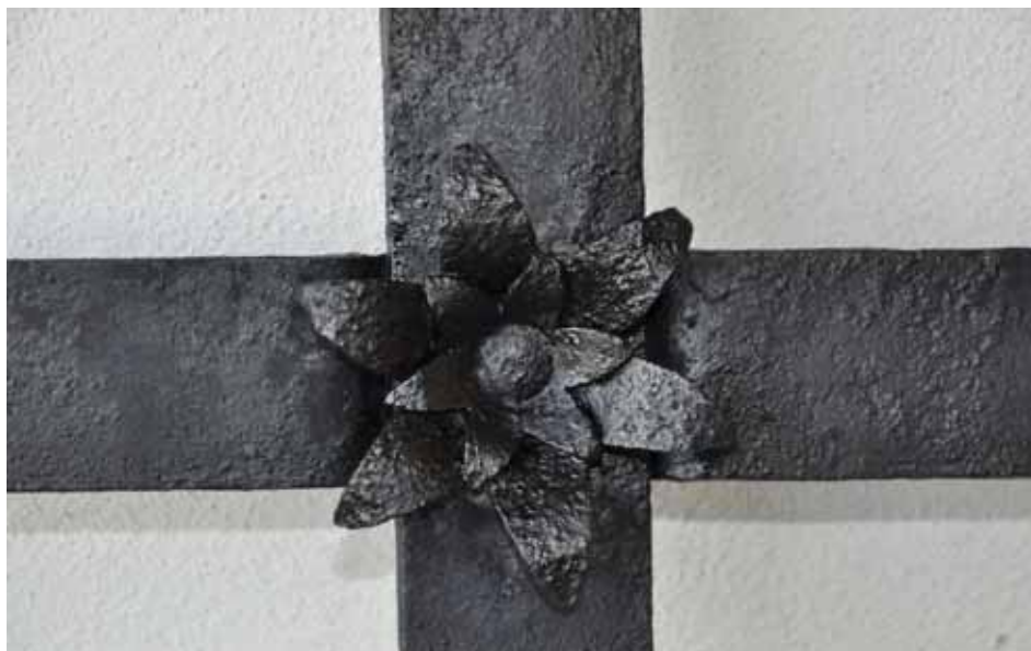
Ozdobná růžice na spojení pásů kříže. Její střed je tvořen hlavou spojovacího nýtu. Foto: František Krejča, SJ ČR
