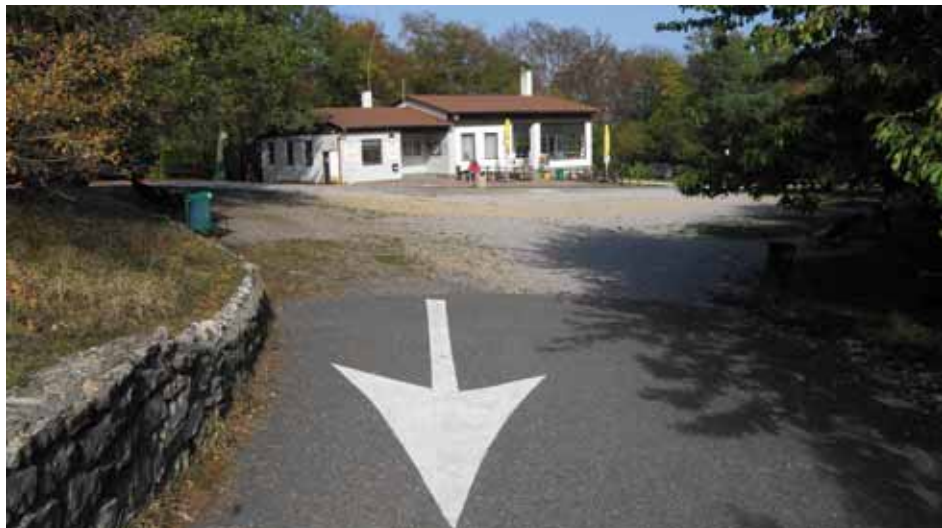
Provozní budova Koněpruských jeskyních z 50. let minulého století. Foto: Vladimír Svoboda, SJ ČR
