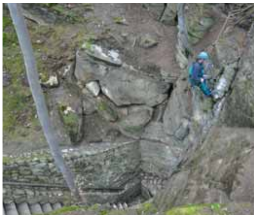
Přípravné práce na zachycení uvolněného bloku a jeho následný přesun s využitím prostředků jednolanové techniky. Foto: Josef Vandělík, SJ ČR
