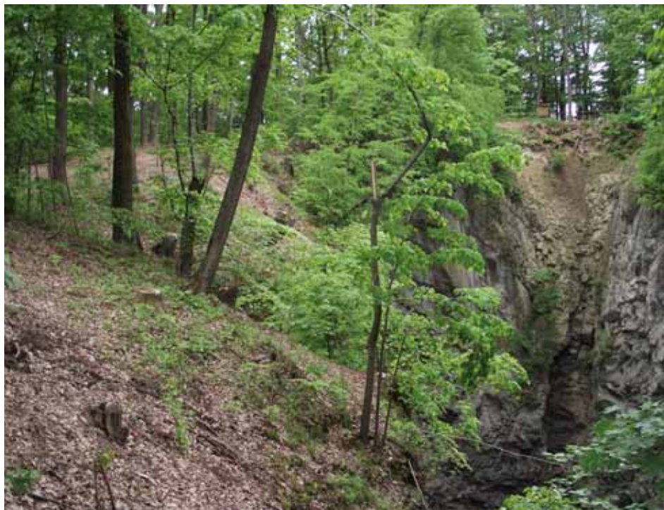
Hranická propast po první etapě kácení rizikových stromů. V pravé části snímku patrná výrazná eroze skalní stěny po „vykloubení“ buku koncem roku 2017. Foto: Barbora Šimečková, SJ ČR
