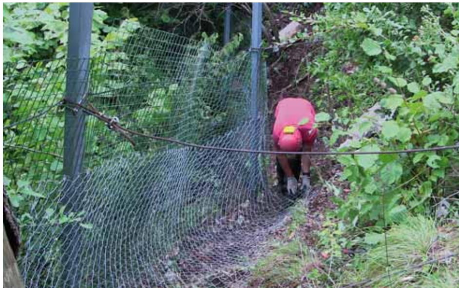
Oprava záchytných plotů nad skalní stěnou u Punkevních jeskyní. Foto: Alois Nejezchleb
