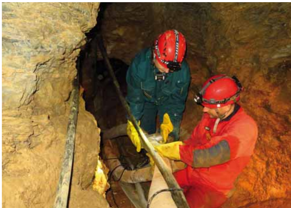
Instalace odsávacích hadic v prostoru Běčko ve Zbrašovských aragonitových jeskyních. Foto: Slavomír Černý, SJ ČR
