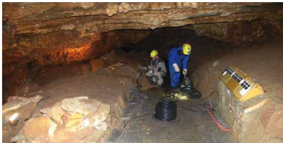
Výměna kabeláže a palubkových světel pracovního okruhu III přes Proškův dóm. Foto: Vladimír Svoboda, SJ ČR
