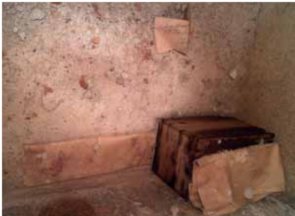
Snímek z průzkumné minisondy, pohled do zazděné niky.
