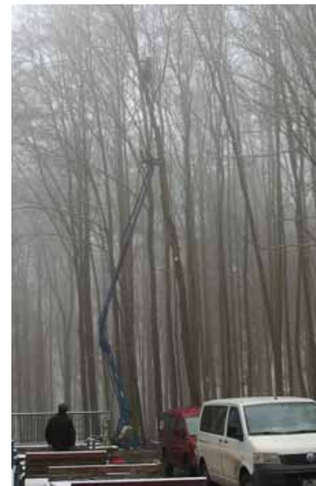
Pokácet vzrostlé buky a nepoškodit přitom budovu, to chce techniku a odvážné chlapy.
