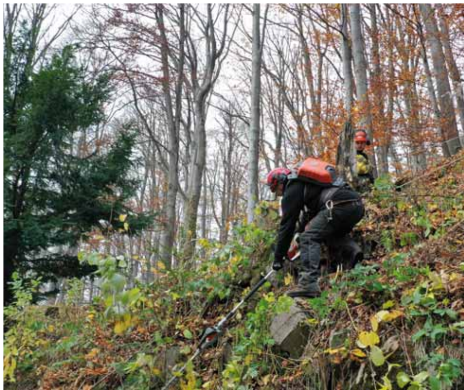
Jirka Augustynek při údržbě lomových stěn v areálu Jeskyně Na Špičáku.
