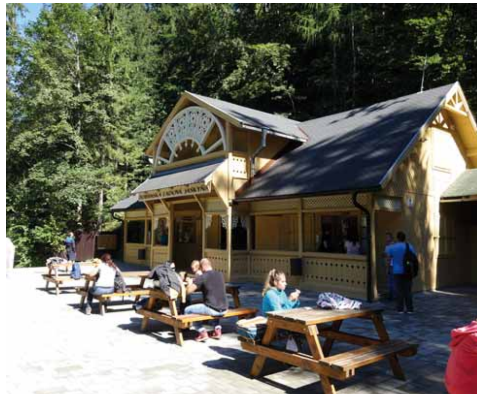
Historický vstupní areál Dobšinské ledové jeskyně je nově zrekonstruován. Foto: Jaroslav Hromas, SJ ČR
