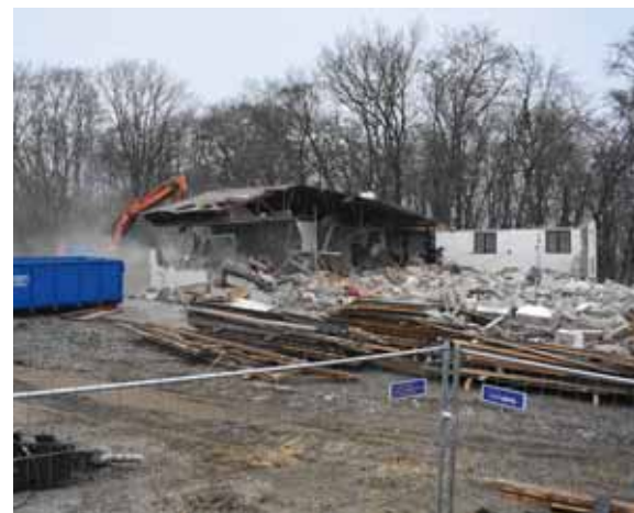
Bourání staré správní budovy Koněpruských jeskyní. Foto: Vladimír Svoboda, SJ ČR
