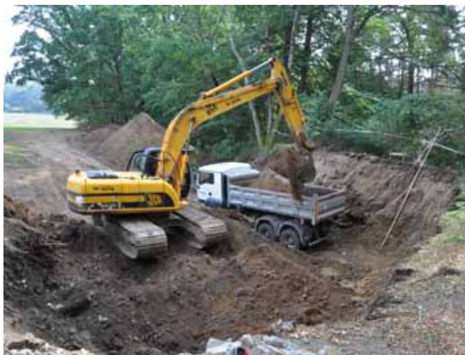
Zemní práce v prostoru budoucí expozice.
