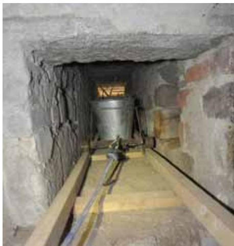
Pro dopravu materiálu bylo v nízké chodbě instalováno provizorní dřevěné kolejiště.
