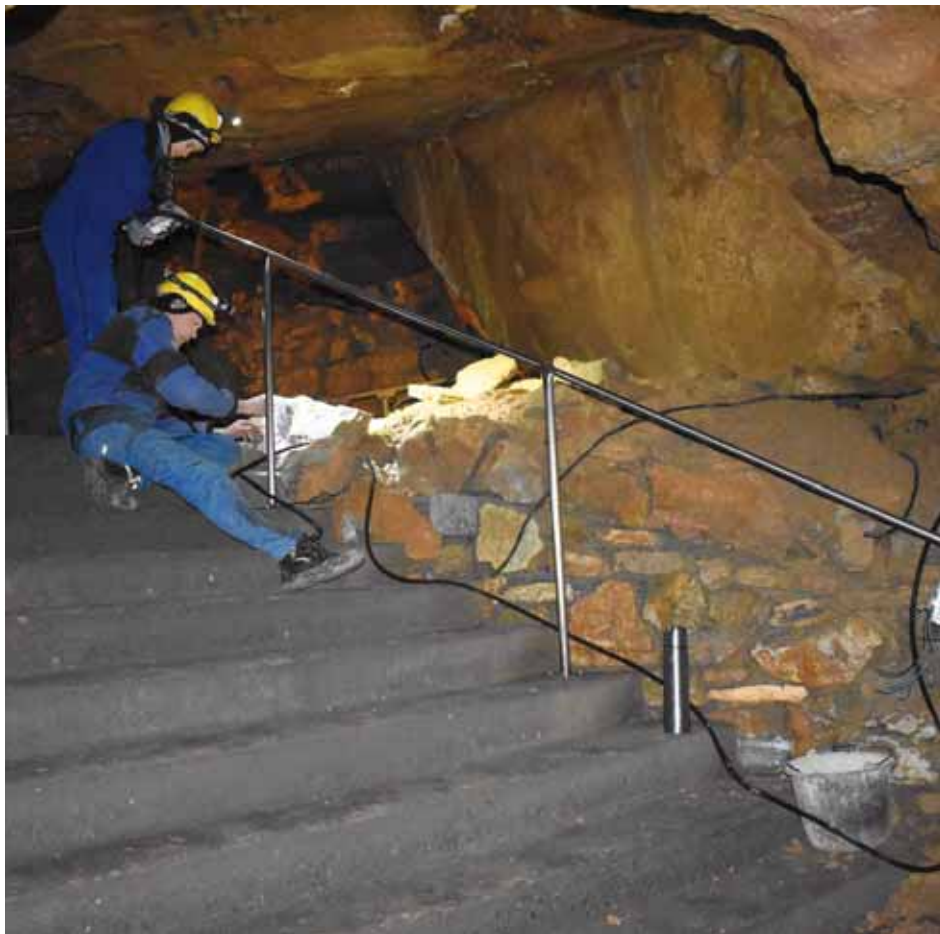
Výměna kabeláže pracovního osvětlení přes Kukulův dóm. Foto: Vladimír Svoboda, SJ ČR
