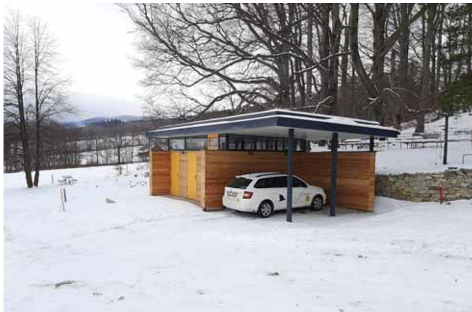
V provozním areálu Jeskyně Na Špičáku vyrostlo po rekonstrukci nové sociální zařízení pro návštěvníky spojené s krytým parkovacím místem pro služební vozidlo. Foto: Evelynna Vozábalová, SJ ČR
