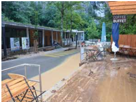
Likvidace následků přívalové povodně v areálu Punkevních jeskyní. Foto: Jiří Hebelka, SJ ČR
