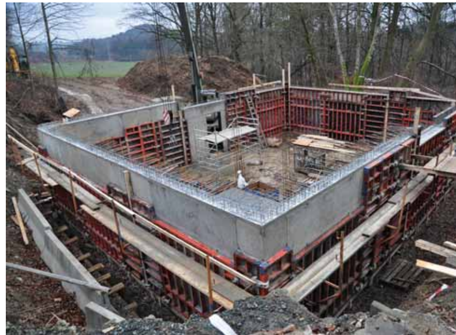
Stavba podzemní části návštěvnického střediska Chýnovské jeskyně. Foto: Josef Vandělík, SJ ČR
