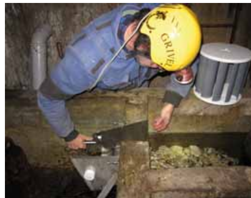
Josef Vandělík při instalaci malé vodní elektrárny. Foto: František Krejča, SJ ČR
