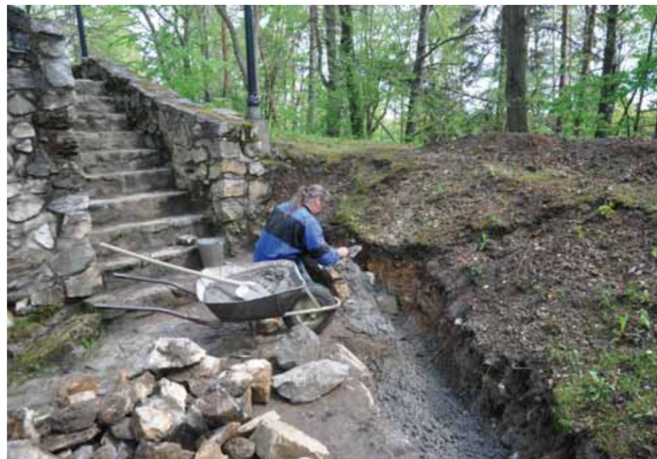
František Krejča staví novou opěrnou zidku u východu z Chýnovské jeskyně. Foto: Hana Štěrbová, SJ ČR
