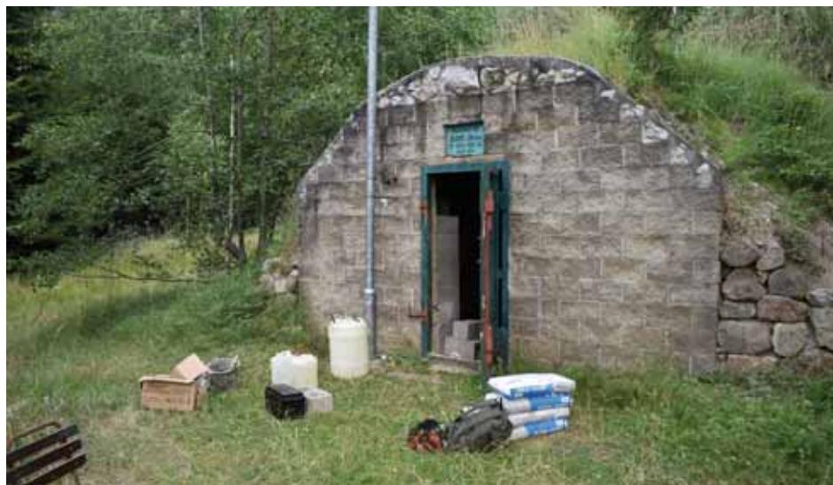
Oprava a zesílení stěn vstupu do Jeskyně Pod Sněžníkem. Foto: Vladimír Svoboda, SJ ČR
