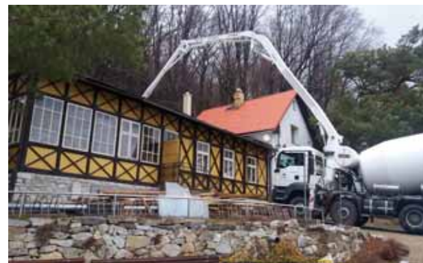
Betonování podlah provozní budovy Jeskyně Na Špičáku.
