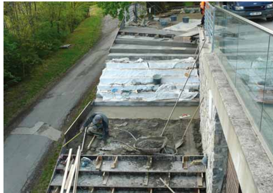
Oprava přístupového schodiště k Mladečským jeskyním. Foto: Drahomíra Coufalová, SJ ČR
