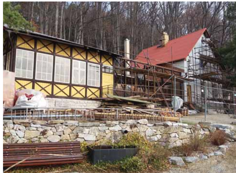
Rozhodnuto! Střed budovy půjde dolů a postaví se replika. Foto: Evelyna Vozábalová, SJ ČR
