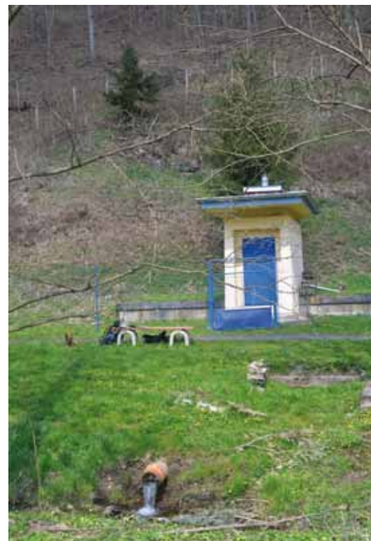
Kras U Šmelcovny – část vodárenského objektu se zatrubněným vývěrem Nad Hálovým mlýnem I. Vchod do jeskyně Nad Hálovým mlýnem se nachází ve svahu nad vodárnou pod smrkem. Foto: Olga Suldovská, SJ ČR
