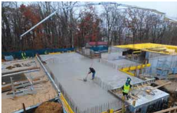
Betonování podzemních částí budoucího Domu přírody Českého krasu.
