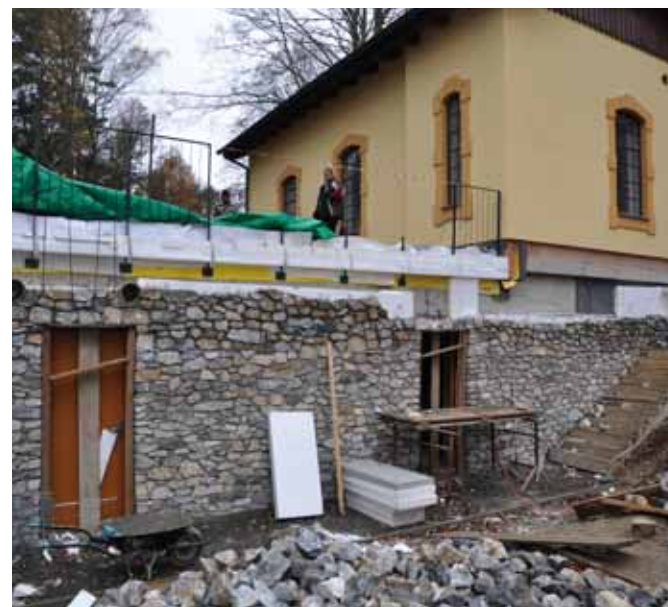
Obklad východní stěny spodní budovy z místního formátovaného kamene.
