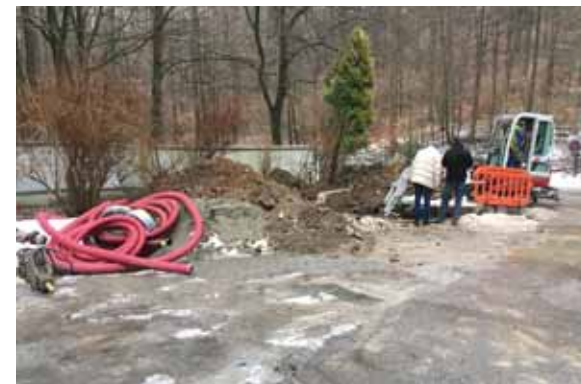
Pracovníci firmy Moyses pod dozorem technika SJMK Pavla Krátkého budují novou přípojku vody k jeskyni Výpustek, kvalitně a za co nejmenší náklady. Foto: Libor Lánik, SJ ČR
