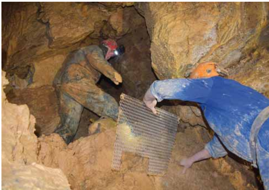
Miroslav Vaněk a Bedřich Zatloukal osazují nerezovou zábranu proti sesuvu bahnitých sedimentů z komína Mazurka ve Zbrašovských aragonitových jeskyních. Foto: Slavomír Černý, SJ ČR
