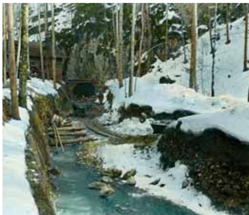
Stavba odvodňovací štolý z Punkevních jeskyní, 1929. Archiv SJ ČR
