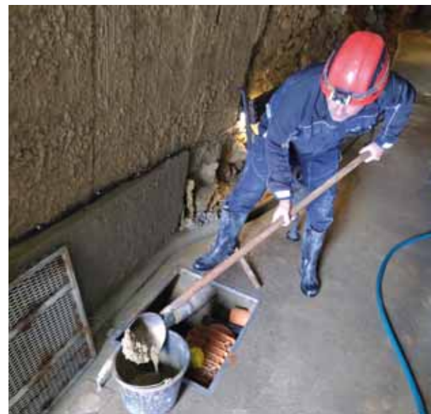
Ivo Koryčánek čistí přečerpávací jímky kanalizačního systému ve východovém tunelu z jeskyní. Foto: Slavomír Černý, SJ ČR
