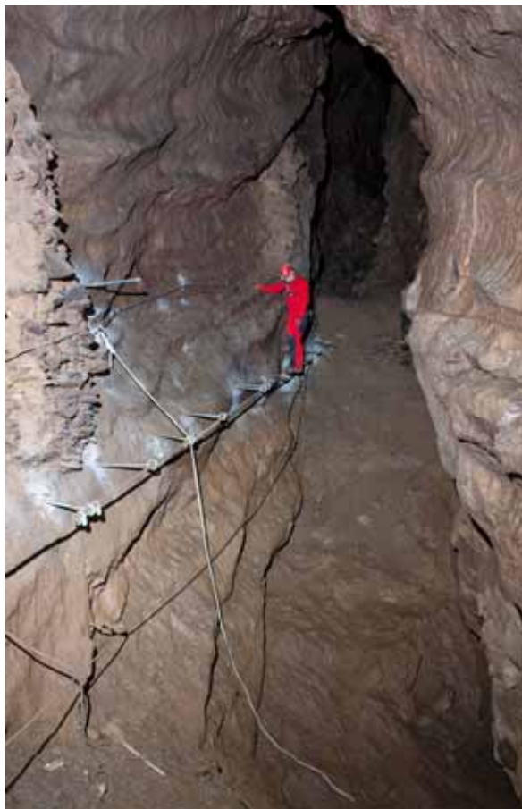
Hlavní důlní měřič Vratík Ouhrabka kontroluje novou jednostopou lávku nad propadem počvy ve Spodním patře Sloupsko-šošůvských jeskyní. Foto: Petr Zajíček, SJ ČR
