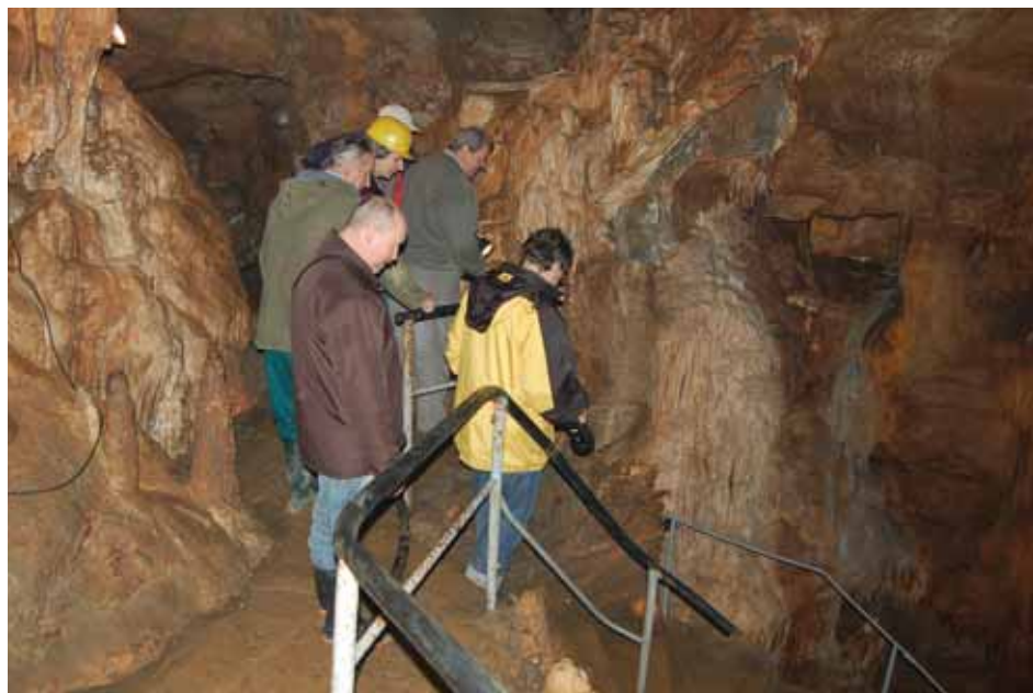
Kontrolní den generální rekonstrukce jeskyně Balcarky v roce 2008 za účasti inspektorů OBÚ Brno. Foto: Jiří Hebelka, SJ ČR
