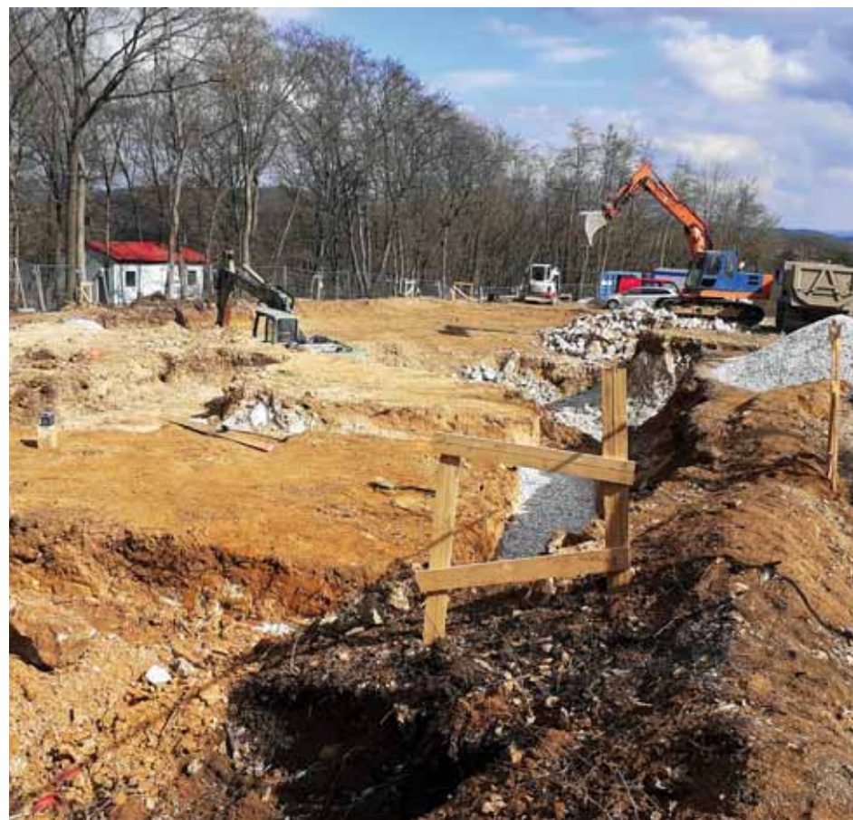
Hloubení základů budoucího Domu přírody Českého krasu u Koněpruských jeskyní.
