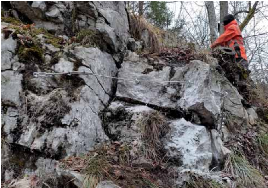
Kotvení nestabilního skalního bloku nad vchodem do Kateřinské jeskyně. Foto: Lubomír Chlup
