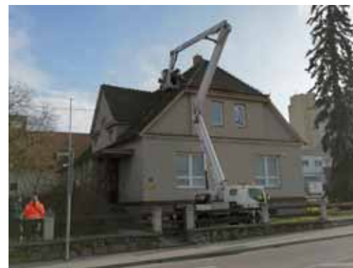
Oprava střechy na budově Správy jeskyní Moravského krasu v Blansku. Foto: Pavel Krátký, SJ ČR
