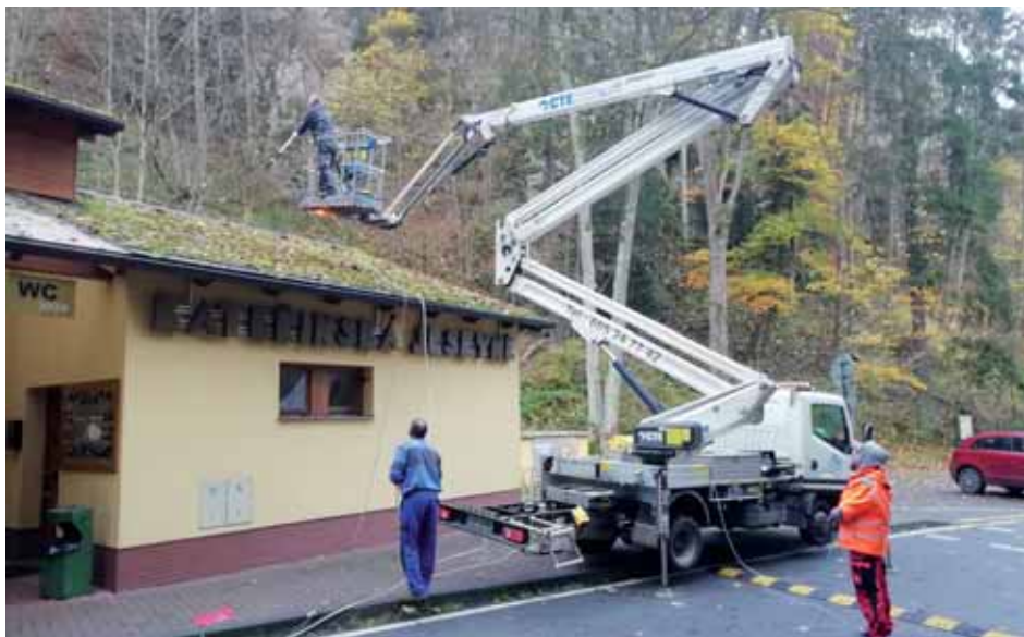
Odstranění mechového porostu ze střešky provozní budovy. Foto: archiv KJ
