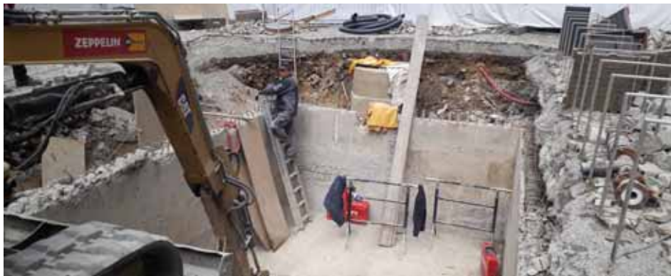
Čilý stavební ruch při betonování základů altánu a venkovních úpravách před Domem přírody Českého krasu. Foto: Tomáš Vinš, SJ ČR
