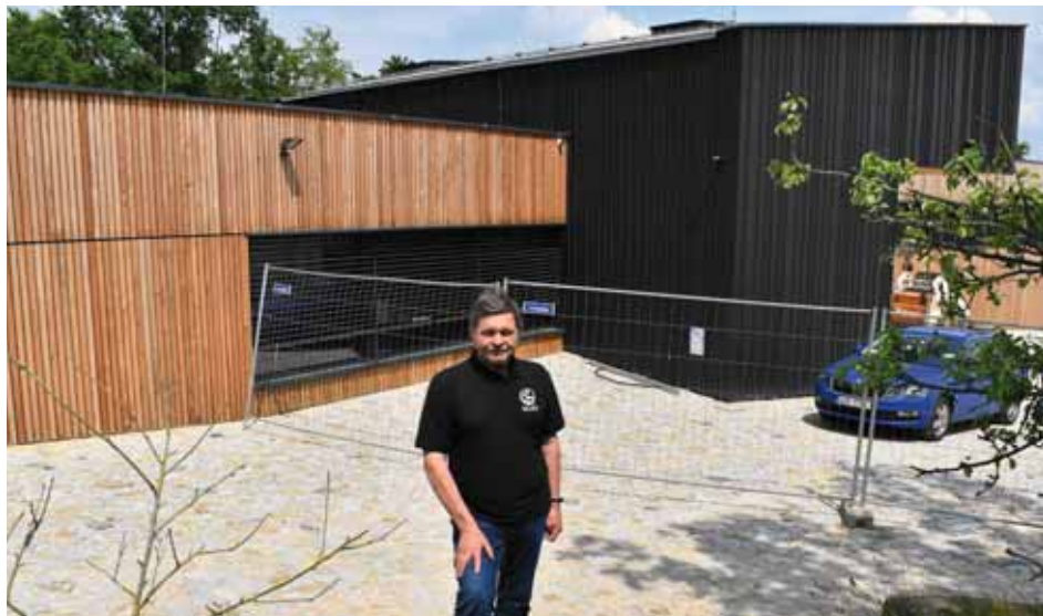
Ředitel Správy jeskyní ČR Ing. Lubomír Příbýl při kontrole postupu prací na stavbě Domu přírody Českého krasu u Koněpruských jeskyní. Foto: Vladimír Svoboda, SJ ČR
