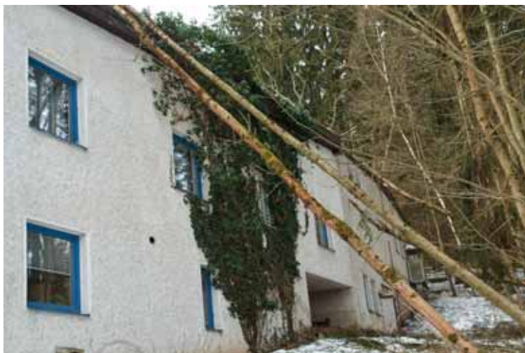
Po vichřici ohrožovaly spadlé stromy provozní budovu Bozkovských dolomitových jeskyní.
