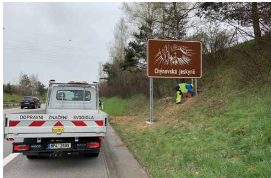
Montáž poutače Chýnovské jeskyně na dálnici D3. Foto: realizační dokumentace, archiv SJ ČR
