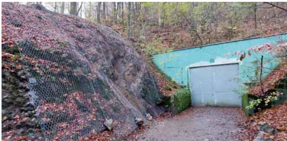
Zpevnění svahu u Transportního vjezdu do jeskyň Vypustek ocelovými sítěmi. Foto: Jaroslav Šanda, SJ ČR.
