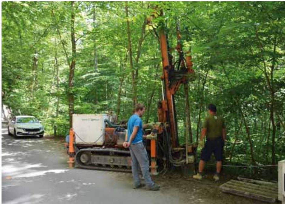
Inženýrsko-geologický průzkum břehového svahu mezi Skalním mlýnem a Punkevními jeskyněmi. Foto: Jakub Gabriš, SJ ČR
