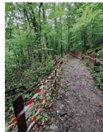
Oprava ochranných plůtků kolem naučné stezky k Hranické propasti. Foto: Tomáš Zlámal
