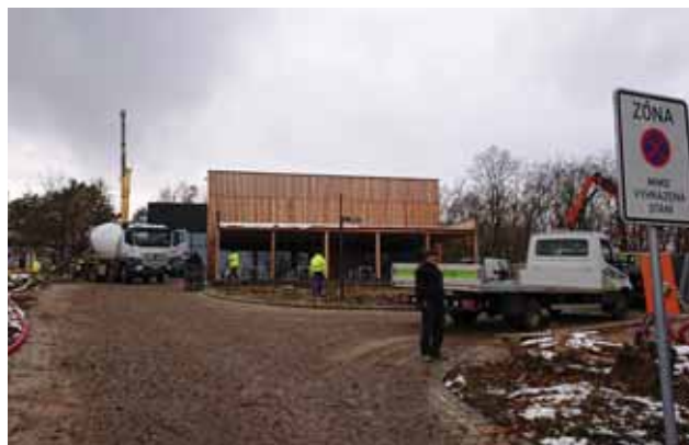
Cílý stavební ruch při betonování základů altánu a venkovních úpravách před Domem přírody Českého krasu. Foto: Tomáš Vinš, SJ ČR
