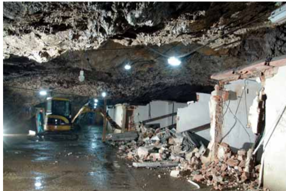
Jindřichův sál v červnu 2007 – stavební firma se energicky pouští do likvidace vezděných objektů. Foto: Jan Flek, SJ ČR
