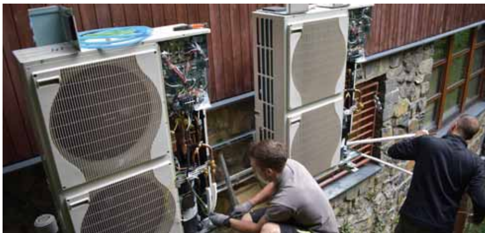
Instalace dvou tepelných čerpadel na jižním průčelí provozní budovy Zbrašovských aragonitových jeskyní. Foto: Slavomír Černý, SJ ČR
