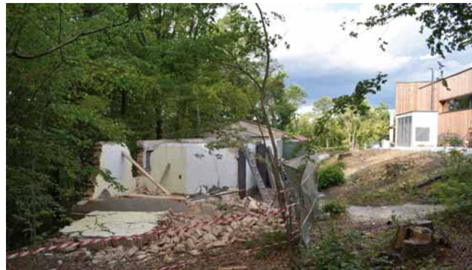
Bourání starého elektrokladu, vpravo již nový objekt Domu přírody Českého krasu.
