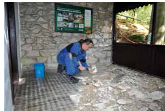
František Krejča při opravě verandy historické pokladny.
