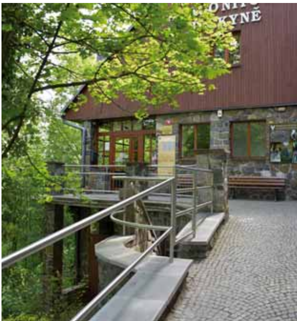
Nové nerezové zábradlí podél přístupového chodníku k provozní budově. Foto: Barbora Šimečková, SJ ČR
