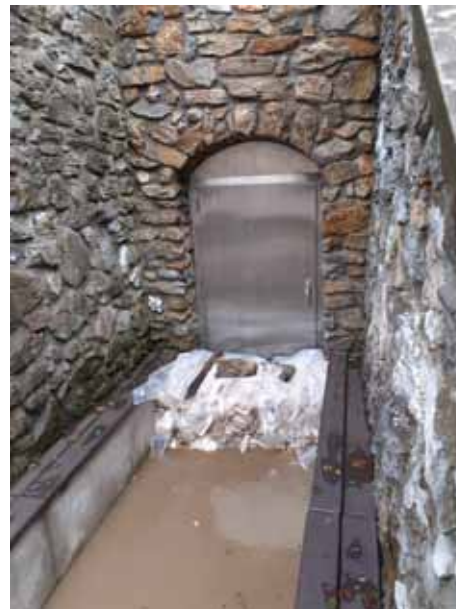
Zajištění východu ze Zbrašovských aragonitových jeskyní. Voda nakonec kulminovala v úrovni dveří kliky. Foto: Barbora Šimečková, SJ ČR
