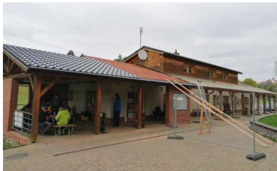
Tomu se říká pech – při zářijových povodních protekla voda i do provozní budovy jeskyně Balcarka, protože zde právě probíhala celková rekonstrukce střechy. Foto: Pavel Krátký, SJ ČR
