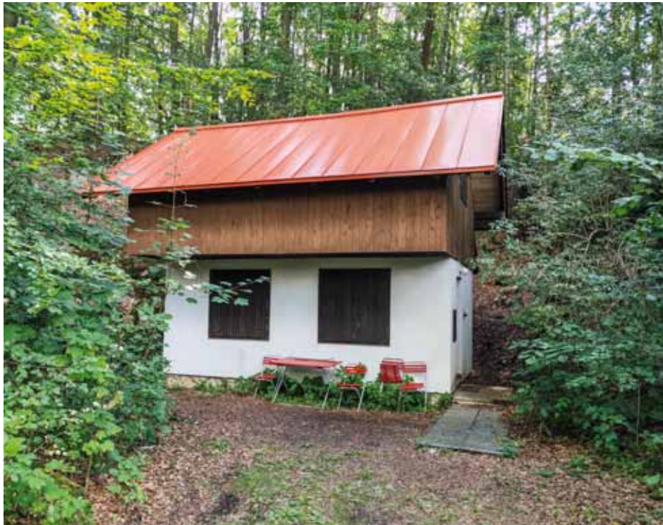
Strub po dokončení s novou hliníkovou střechou. Foto: Dušan Milka, SJ ČR
