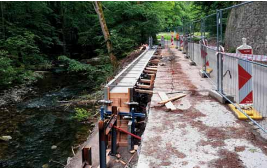
Zajištění břehového svahu Punkvy a stabilizace účelové komunikace v úseku Skalní mlýn – Pustý žleb. Foto: Jakub Gabriš, SJ ČR
