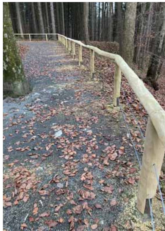
Nový úsek zábradlí od východu z jeskyní k provozní budově. Foto: Martin Kubalák, SJ ČR
