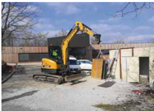
Odvozu poslední stavební buňky, která sloužila jako pokladna, předcházelo vystěhování starého trezoru, zabudovaného předtím dlouhá desetiletí v bývalé správní budově.
