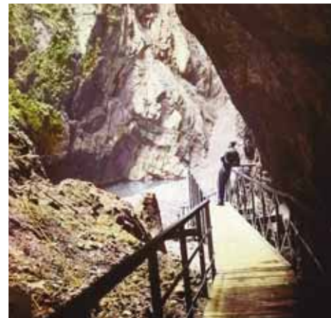
Chodník na dno Macochy po zpřístupnění v roce 1914. Archiv SJ ČR
