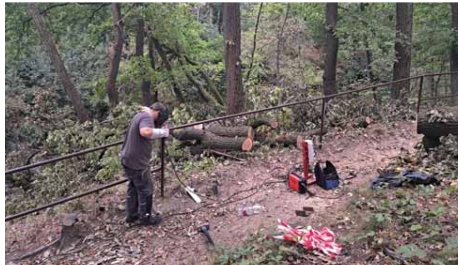
Karel Sedláček při opravě zábradlí kolem Hranické propasti poničeného pádem stromů. Foto: Tomáš Zlámal
