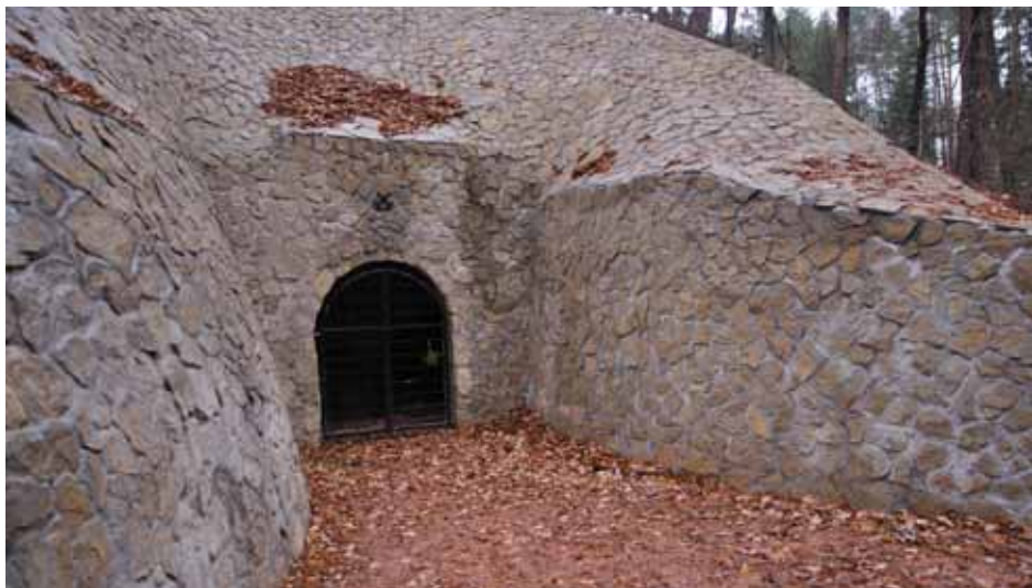
Téměř zřícený vstup do důlního díla Orty byl v roce 2020 zajištěn masivním kamenným portálem. Foto: Josef Vandělik, SJ ČR
