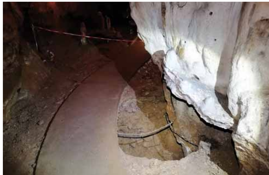
Vznik nového trativodu a propad chodníku na návštěvní trase v jeskyni Balcarce. Foto: Pavel Krátký, SJ ČR
