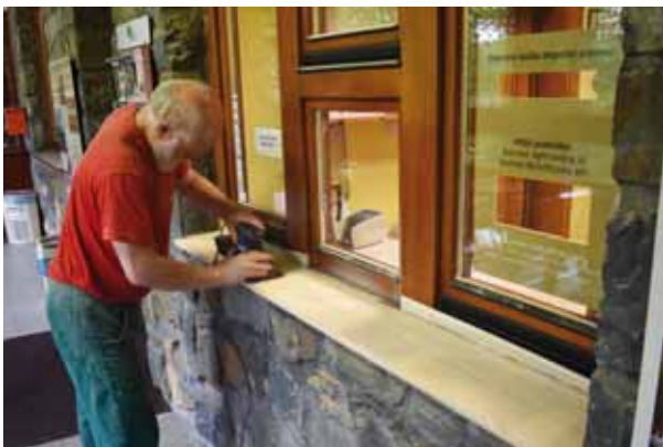
Opravou prošel také parapet u pokladny, jehož původní nátěr byl od doteků návštěvníků vysloveně rozleptaný. Foto: archiv SZAJ
