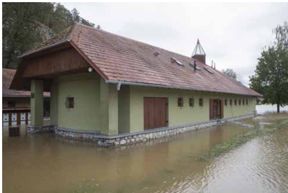
Zatopený provozní areál Sloupsko-šošůvských jeskyní v neděli 15. září 2024 kolem poledne. Foto: Petr Zajíček, SJ ČR
